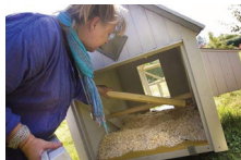
Elisabeth har gjort rengöringen enkelt genom att förse höns husen med avtagbar kortsida.
